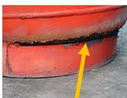
底の塗装が剥がれ、キャップが破損している。
