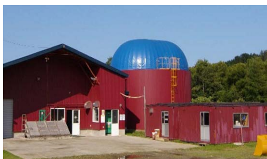
写真 3 支倉牧場バイオガスプラント
