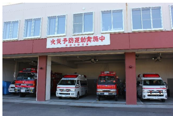
興部支署消防庁舎
