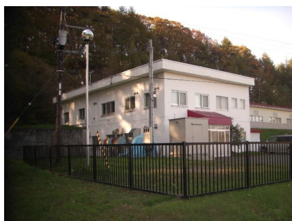
興部浄水場管理棟
