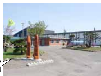
昭和43年に完成した、 築46年の校舎
