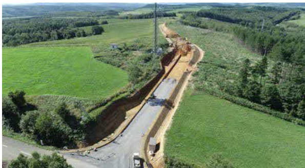
興部秋里間道路改良工事 完成予定：令和20年度
