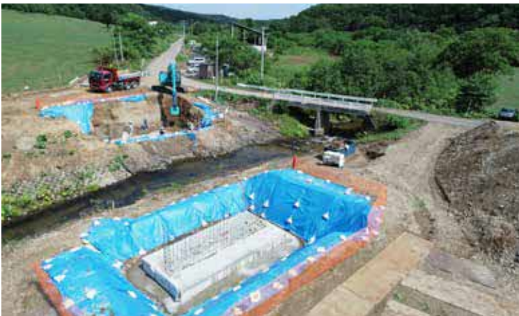
豊畑2号橋の架替工事
