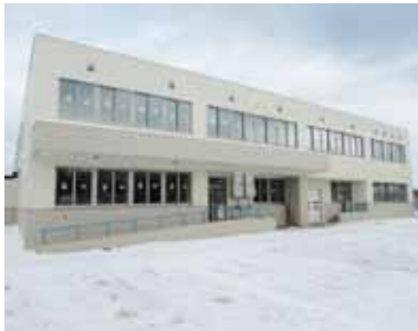
新興部中学校建設工事
