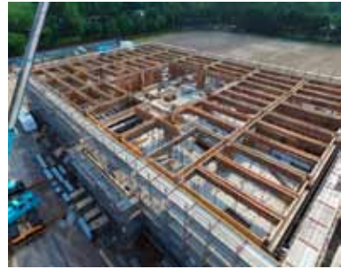
新興部中学校建設工事
