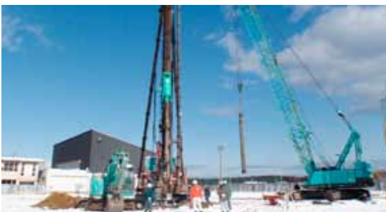
中学校建設工事
