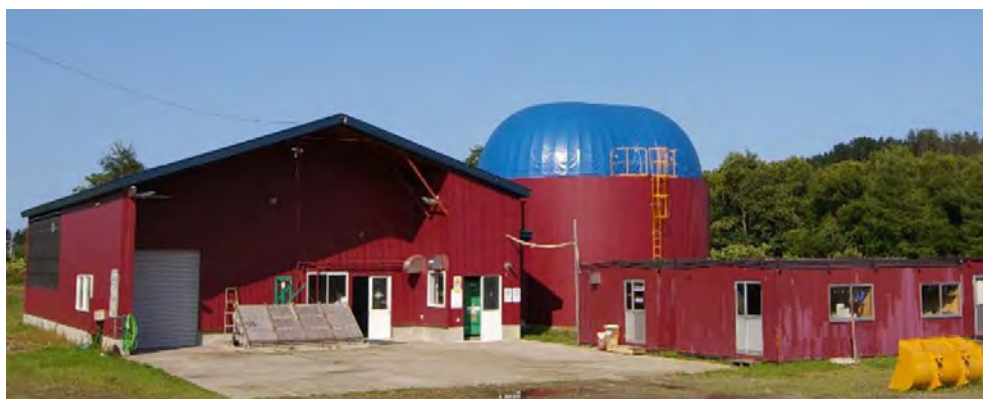
支倉牧場バイオガスプラント
