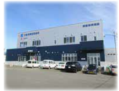
沙留冷凍冷蔵加工施設
