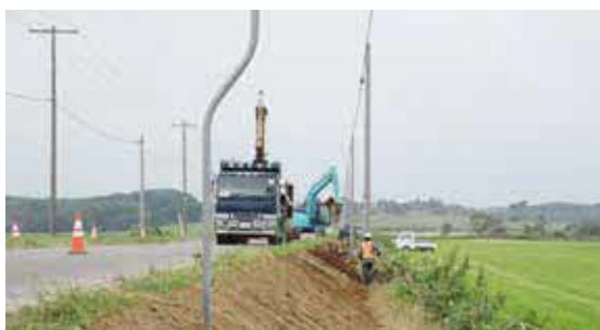
豊野沙留間道路配水管新設工事
