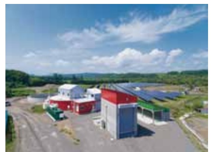
バイオガスプラント
